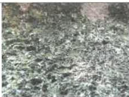
Locul de prelevare a probei nr. 2 - Detaliu soclu cu biodermă vegetală
