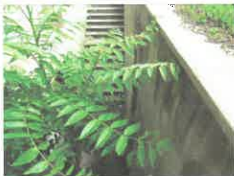
Locul de prelevare a probei nr. 2 - Fațadă Sud Vest - imagine cu starea generală de conservare a soclului - fațadă atacată de vegetație abundentă ce menține umiditatea crescută la acest nivel
