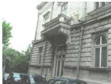
Proba nr. 3 - Fațadă Sud Est - imagine cu starea generală de conservare a fațadei principale - se remarcă apariția arborilor între spațiile lacunare ale zidăriei
